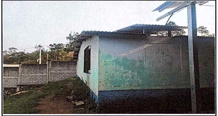
Foto 2: Fachada lateral de la cocina a remozar.
